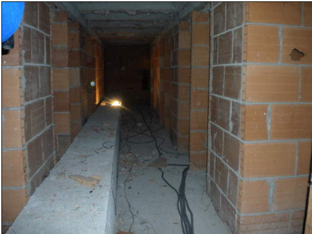
Vespazio di muricci a sostegno della copertura del corpo di fabbrica B2
