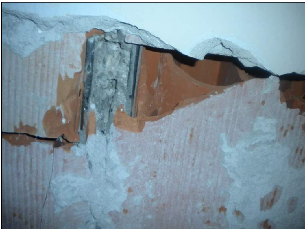
Sondaggio eseguito all'intradosso del solaio di piano primo del corpo di fabbrica B1
