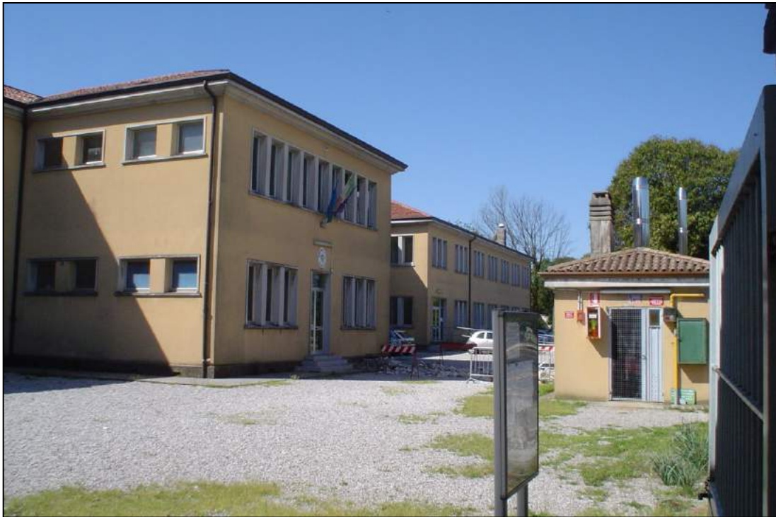
Vista nord-est del complesso scolastico
