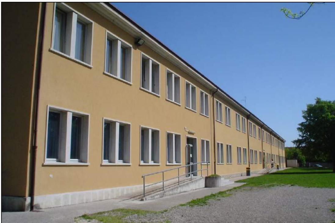
Vista sud del complesso scolastico
