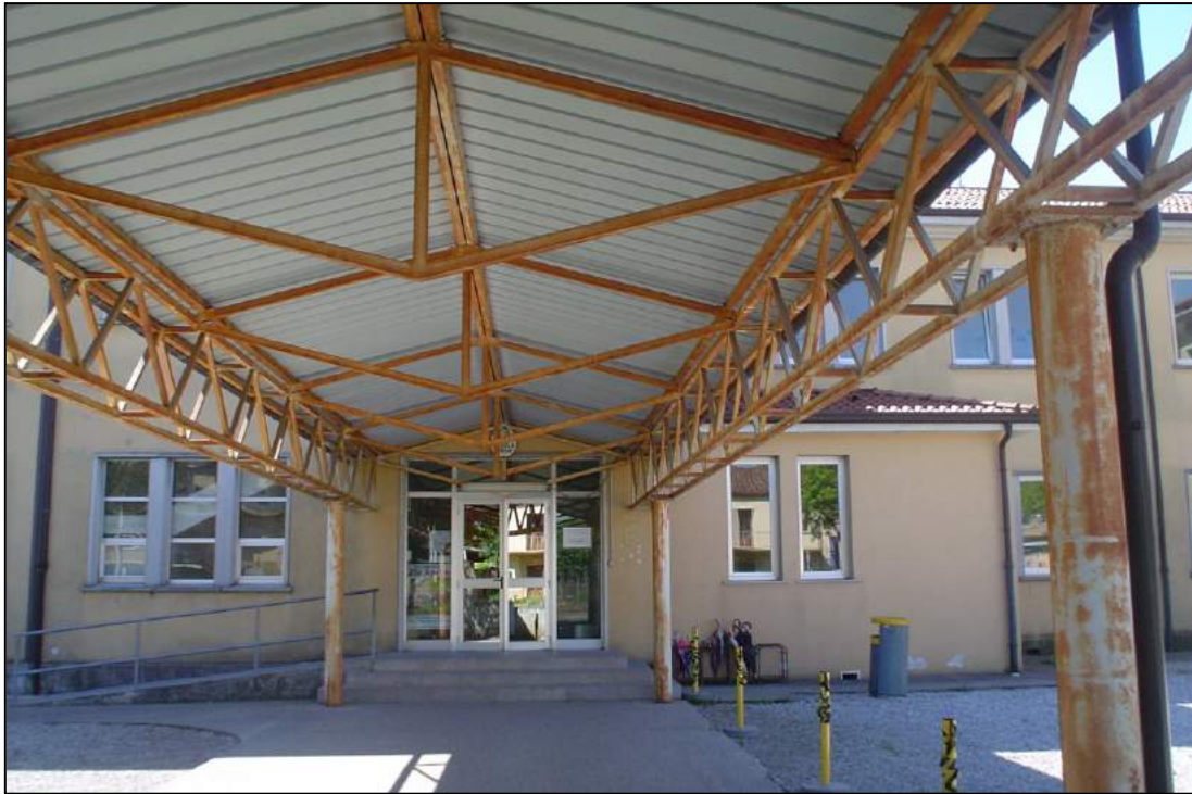
Vista della pensilina di ingresso
