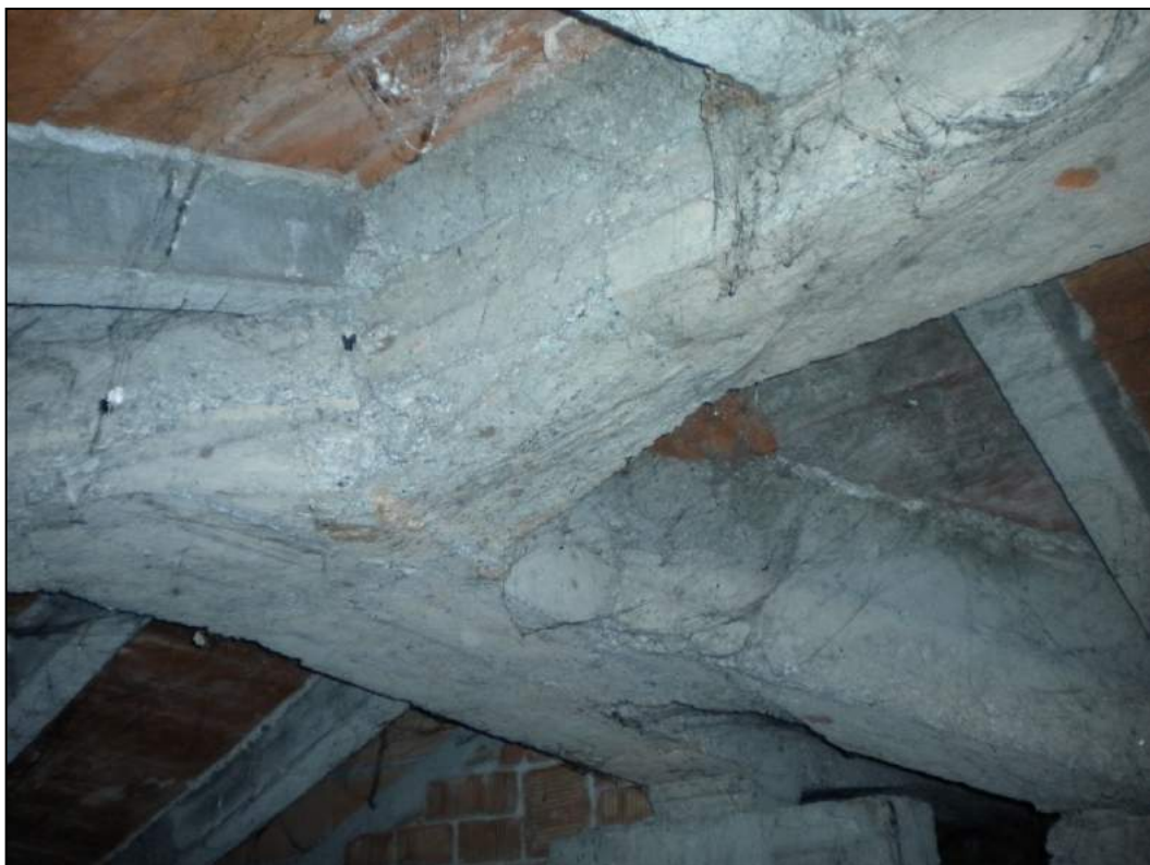
Particolare delle travi del solaio di copertura del corpo di fabbrica B1
